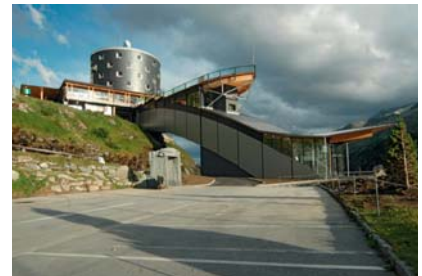
Brückenbaukörper an der Kölnbreinsperre
